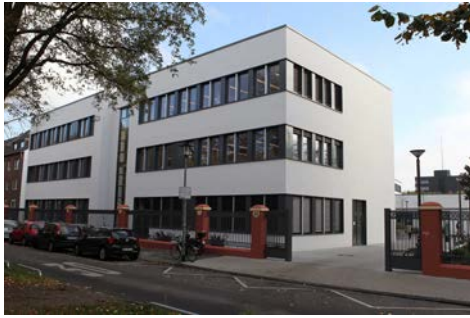
Vorderansicht Multifunktionsgebäude an der Richard-Wagner-Straße 97
