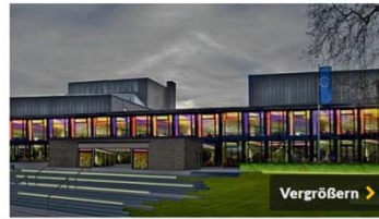
Die Stadt drückt bei der Theatertreppe aufs Tempo. FOTO: Architektenbüro Landschaft + Garten (Papierfuß, Jochims GmbH)
