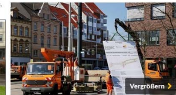
Gestern errichteten Arbeiter vor dem Rathaus das Schild zum nun begonnenen Umbau der Konrad-Adenauer-Straße. FOTO: Koenen, Stephan (TEB)
