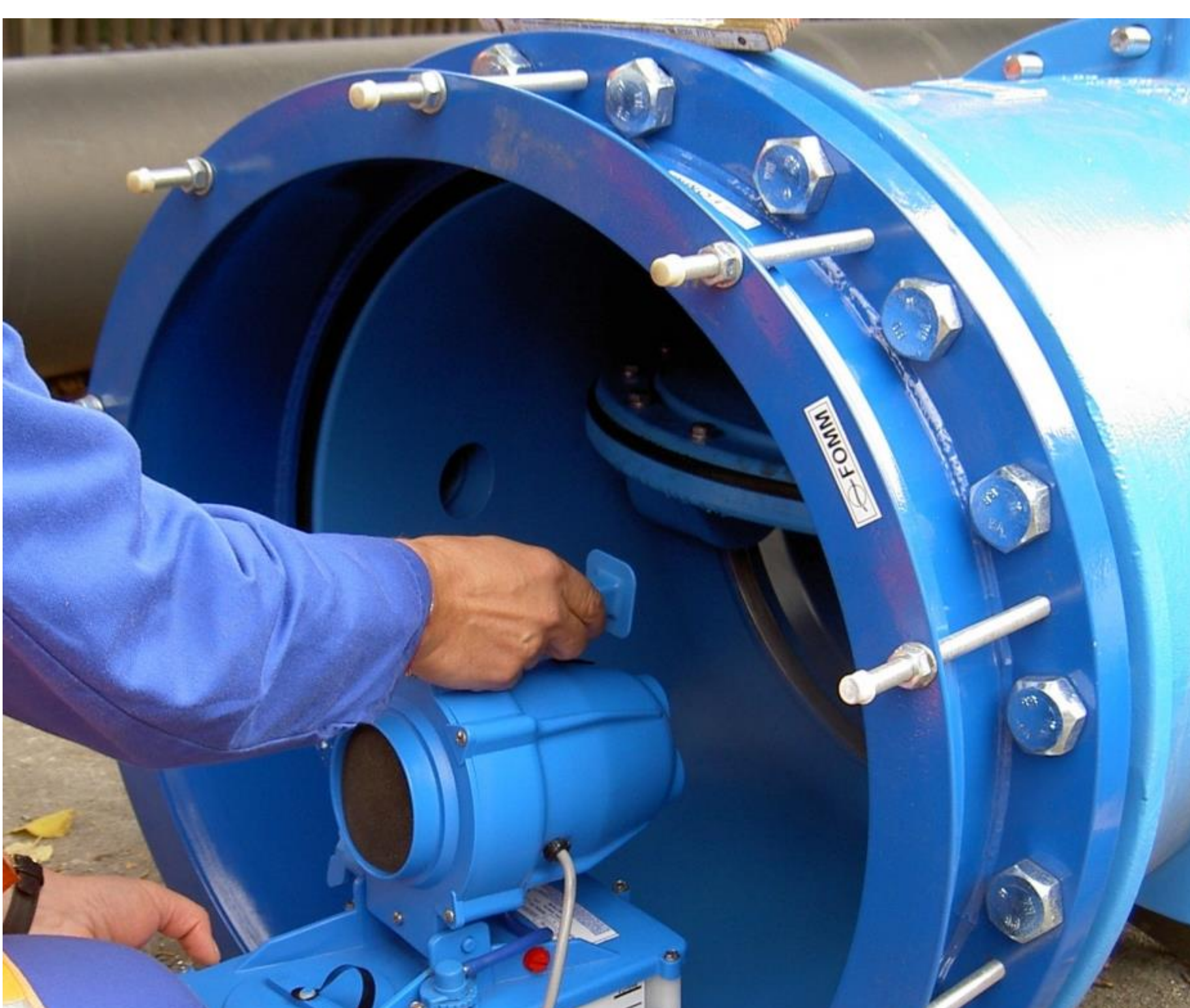
Abbildung 3: Desinfektion von Rohren
