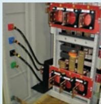
Die roten Bauteile in dieser Anwendung sind mit InsulTemp® behandelt
