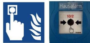
Darüber hinaus sind in der Mehrzahl der Hochschulgebäude **Brandmeldeanlagen** eingebaut. Diese erkennen entweder über automatische Melder eine Brand- bzw. Rauchentwicklung und lösen eine Alarmierung aus oder müssen durch sog. Druckknopfmelder manuell ausgelöst werden. Ein weiterer wichtiger Punkt ist, zu erkennen, ob es sich nur um eine reine (Haus)-Alarmierungsanlage oder eine Brandmeldeanlage mit Aufschaltung auf die Feuerwehr handelt.
